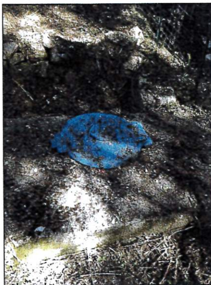
Source de Petraghjolu 2, cuveau de collecte
